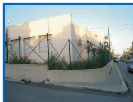
Scuola Infanzia Via Regina Margherita. Adeguamento sicurezza (€ 206.000)
