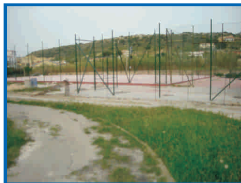
Sistemazione campetti (area giardinata Jungi). Lavori eseguiti € 40.000
