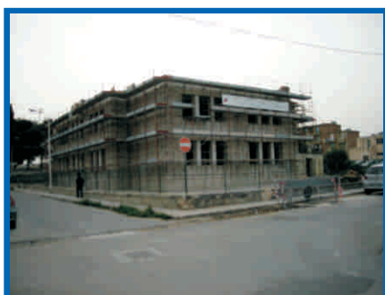
Scuola Elementare Quasimodo sicurezza, impianti, ecc. Lavori in esecuzione (€ 1.346.000)
