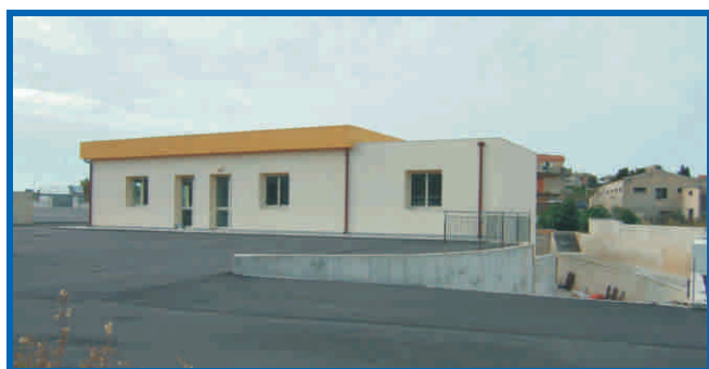
Centro Operativo Misto di Protezione Civile di c.da Zagarone. Lavori eseguiti per un importo di (€ 1.300.000)
