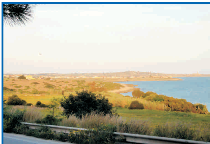
Parco Costa di Carro - lavori in esecuzione € 1.579.987
