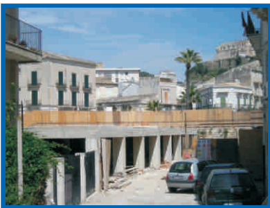
Parcheggio in via Badiula Lavori in esecuzione (€ 1.239.971)
