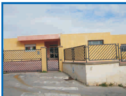
Scuola Materna via Pietro Nenni. Lavori consegnati (€ 295.000)
